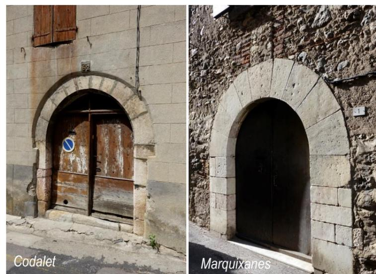
La **composition vernaculaire** repose sur le principe de l'aléatoire pouvant associer des ouvertures de tailles différentes disséminées sans régularité sur la façade selon des nécessités d'usages (entrée de remise, larges ouvertures sous comble pour le séchage du foin, ...).
