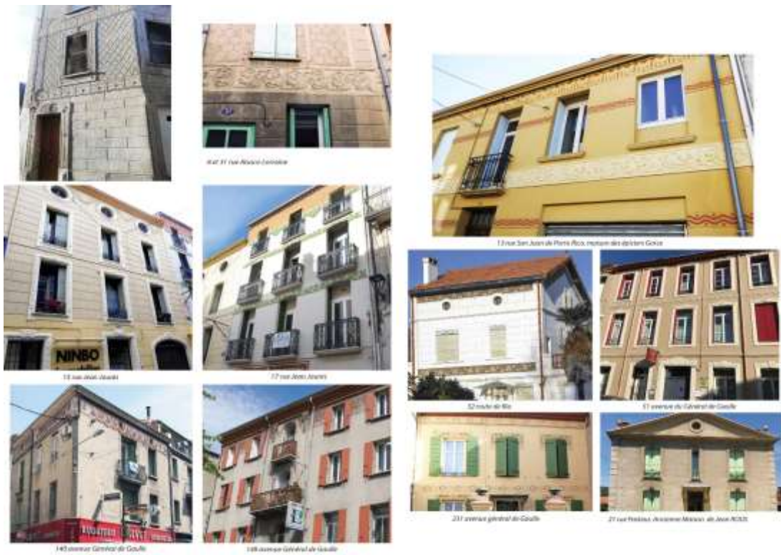
Façades d'habitations avec enduits sculptés à Prades, © Service Patrimoine de Prades
