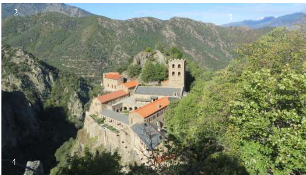
1, 2. et 3. Abbaye Saint-Michel-de-Cuxa, 2017 et 2020, © OT Conflent Canigó © Léonie Deshayes 4. Vue aérienne de Saint-Martin-du-Canigou, 2017, © Léonie Deshayes
