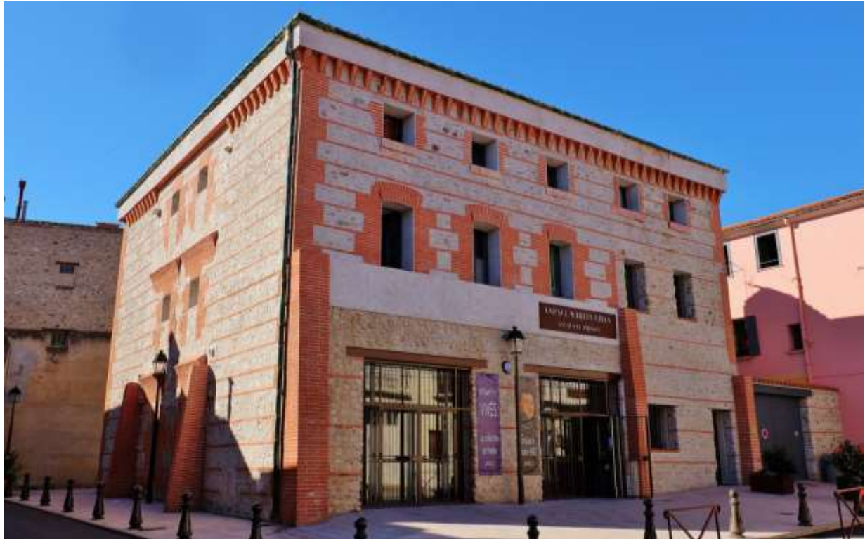
Espace Martin Vivès, Prades, 2020, © service patrimoine de Prades
