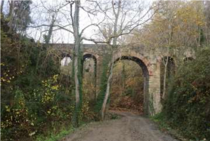
Aqueduc (XIX e siècle) sur le territoire de Clara-Villerach (passage du canal de Bohère), Lieu-dit El Sola Roig, 2021, © Léonie Deshayes
